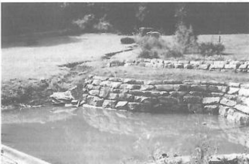
**Bild Nr 4:** Diese Trockenmauer wurde aus Abdeckgestein gebaut. Eine ungerade Zahl von Steinreihen wirkt am schönsten. Besser wäre es gewesen bei so einer großen Anlage etwas dickere Steine zu nehmen, die es erlaubt hätten in nur 3 Lagen zu arbeiten. Eine geschickte Bepflanzung kann dies aber zum größten Teil beheben.
