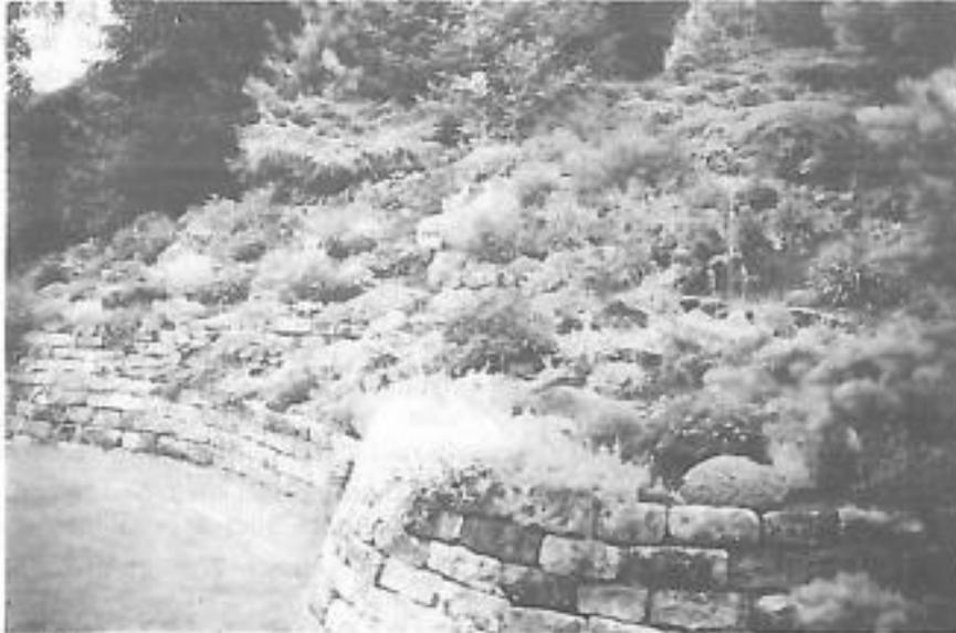
**Bild Nr 5:** Diese Trockenmauer wurde nach allen Regeln der Steinmetzkunst gelegt. Es waren viele bereits zurecht gehauene Steine durch einen Mauerabriß vorhanden, die alsdann wieder in sauberer Ordnung aufeinandergeschichtet wurden. Hier handelt es sich um Sandsteine. Leider ist zwischen den Fugen nicht sehr viel Spielraum geblieben für Steingartenpflanzen.
